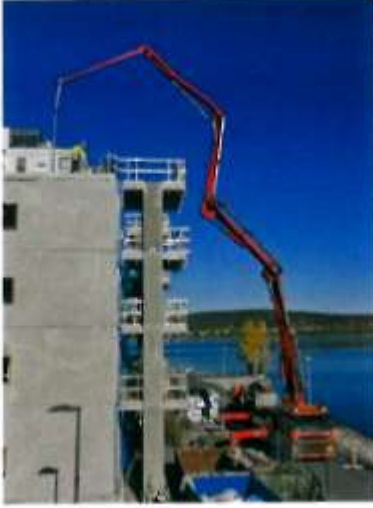
الشكل ١٩ تستعمل بعض المعدات الهيدروليكية في أعمال البناء.
